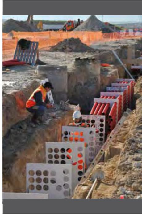
La multitubulaire, qui longe la ligne et accueille l'ensemble des alimentations du tramway, est coulée dans le béton.
