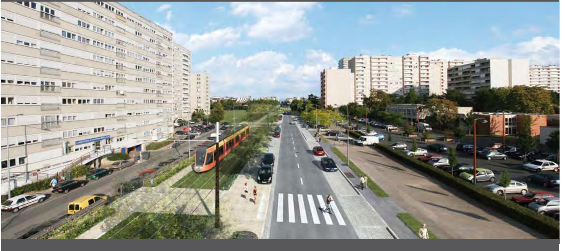
Le tramway circule en site propre sur une plate-forme engazonnée.
