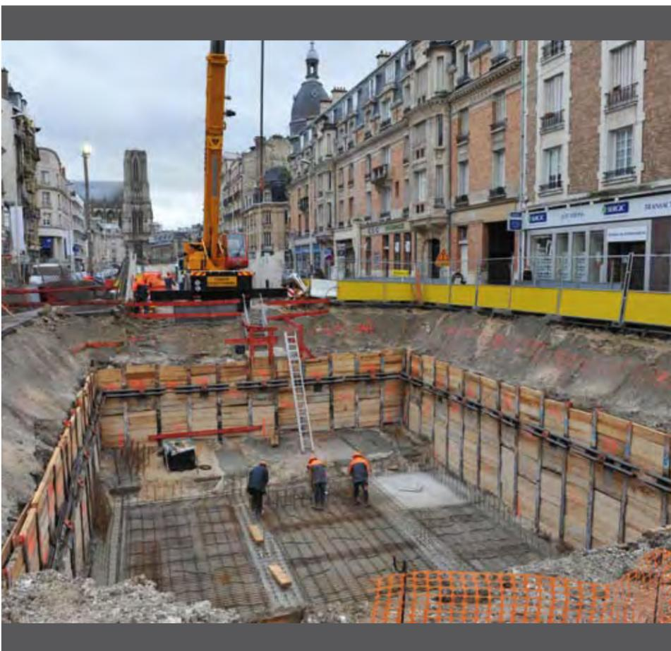
Construction de la sous-station électrique Cours Langlet située sous la plate-forme. Elle fait 6 m de profondeur, 15 m de large et 10 m de long.
